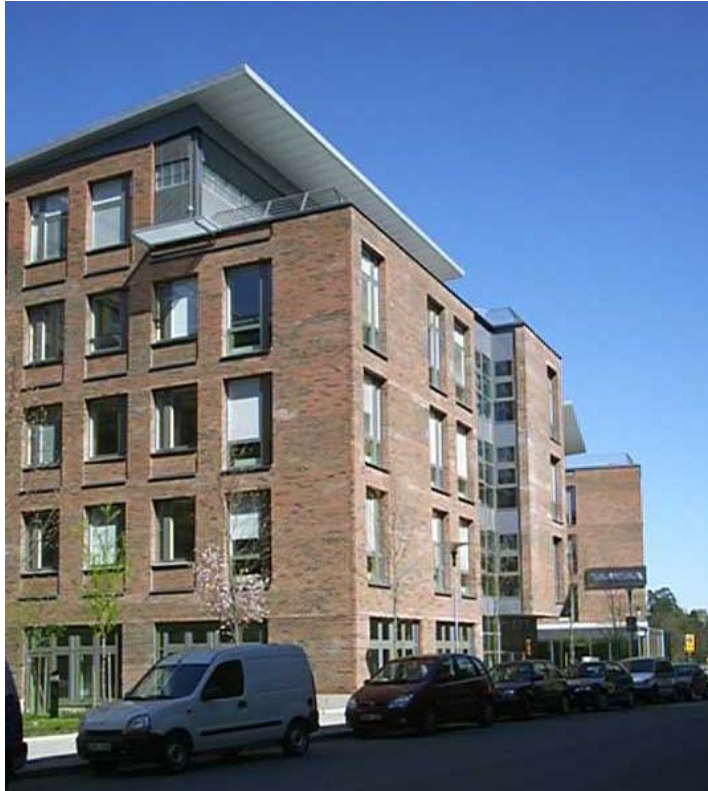
Figur 3 HagaPorten 1 södra fasaden
