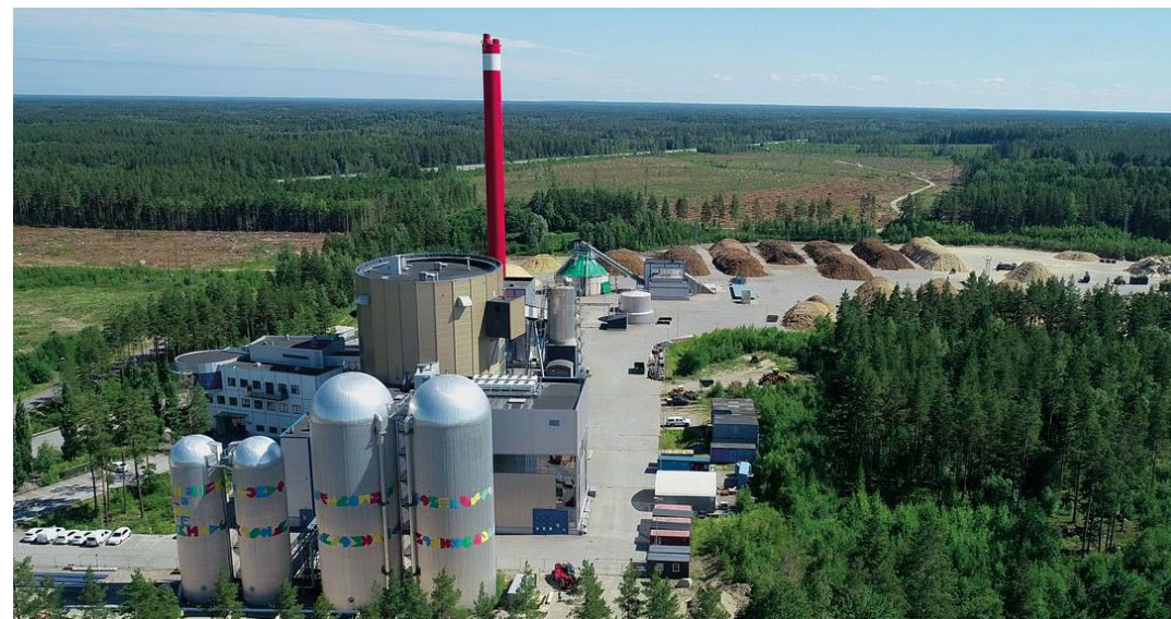
Kraftvärmeverket Johannes i Gävle
