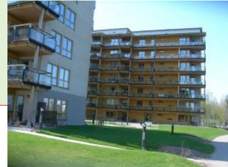
8-vån hus i massivträ, Växjö
