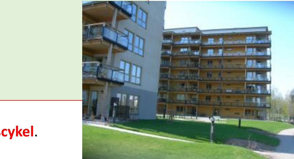
8-vån hus i massivträ, Växjö
